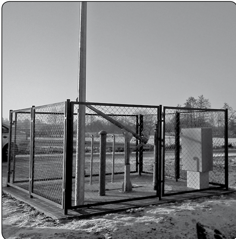
W tym roku zrealizowany został pierwszy etap inwestycji. Budowa zostanie dokończona w przyszłym roku. Koszt inwestycji to ponad 2,6 mln zł.
