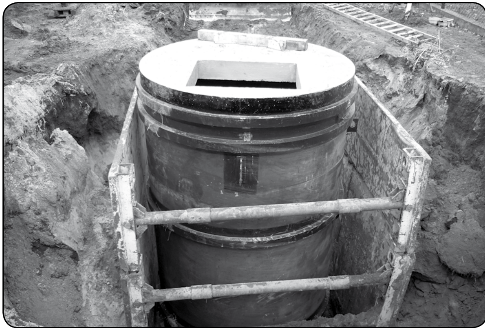
W Rozpędzinach powstanie łącznie ok. 14 km nowej sieci sanitarnej.
